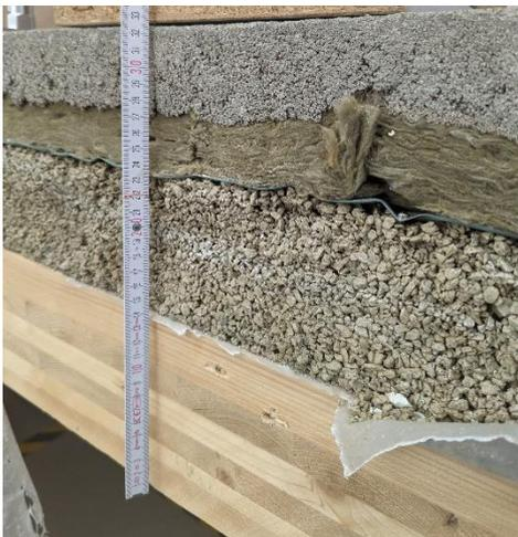
Abbildung 31: Bodenaufbau für die Varianten 11, 12a, 12b
