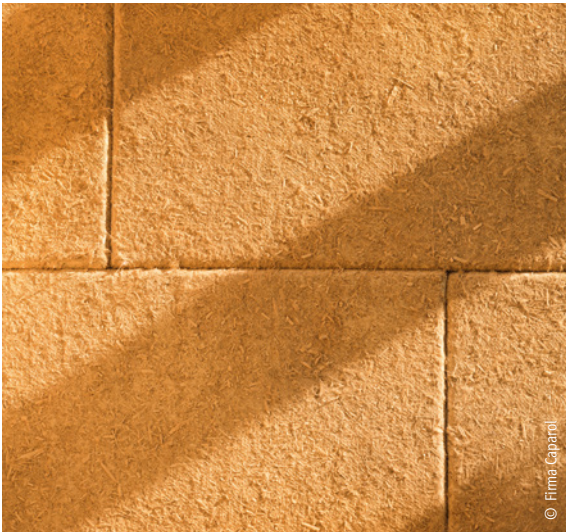
Schallabsorberplatten aus Hanf verbessern die Raumakustik.
